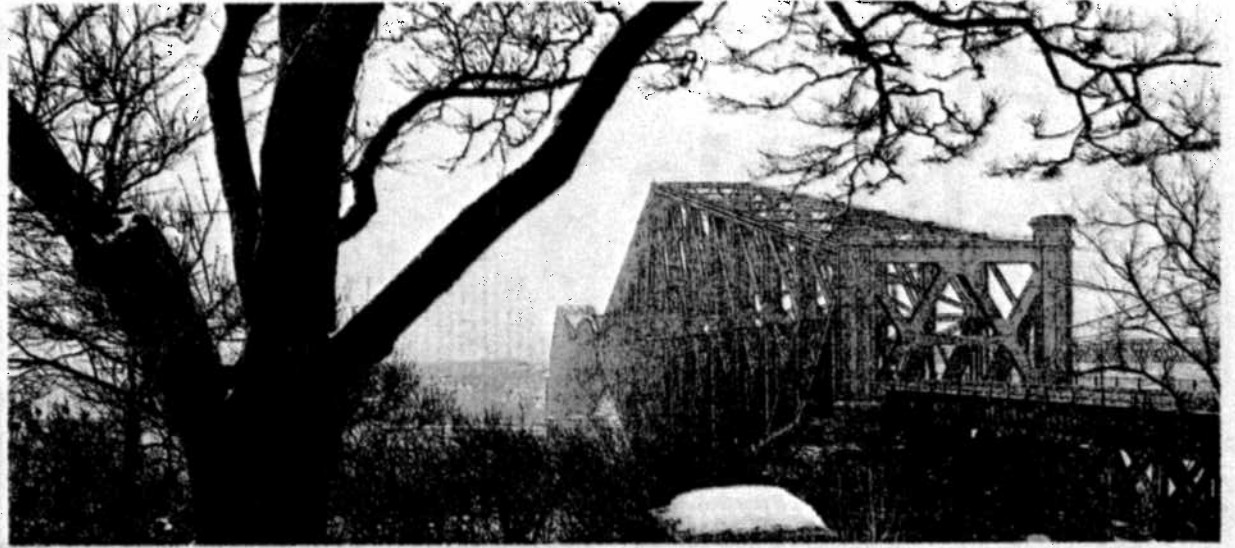
Les trois professeurs veulent comparer l'épaisseur de l'acier au moment de la construction et ce qu'il en reste maintenant pour mieux établir la capacité portante du pont. — PHOTOTHÈQUE LE SOLEIL, JEAN-MAIRE VILLENEUVE
